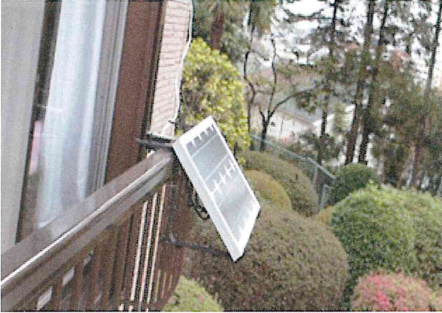
ベランダの手すりにソーラーパネル設置 （青葉区 Sさん宅 20W）
