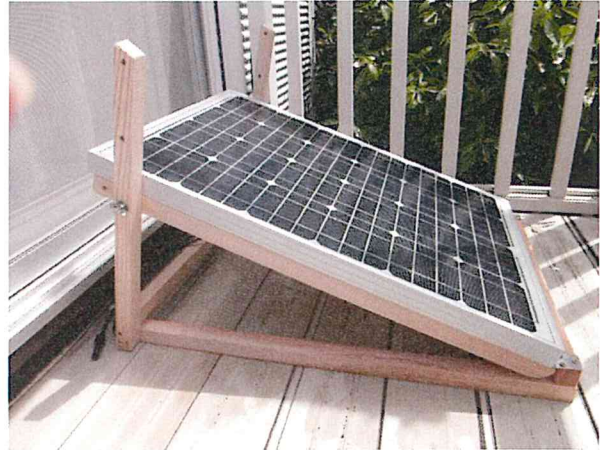
ベランダにソーラーパネルを設置 （大和市 Nさん宅 50W）
